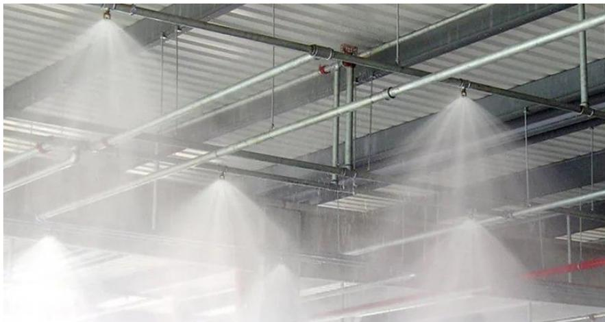
Рис. 2. Пример спринклерного пожаротушения
